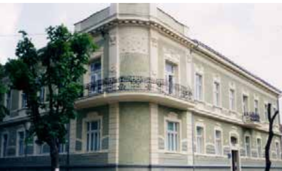
Zgrada Državnog arhiva Slavonski Brod. Foto: Državni arhiv Slavonski Brod
