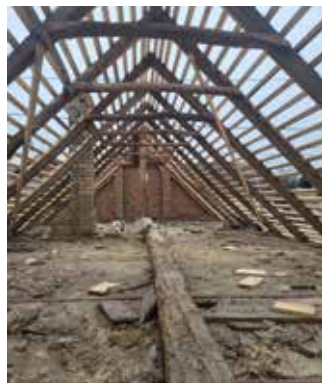
Dom Ocića – radovi na očuvanju baštine. Foto: Udruženje „Đorđe Očić“
